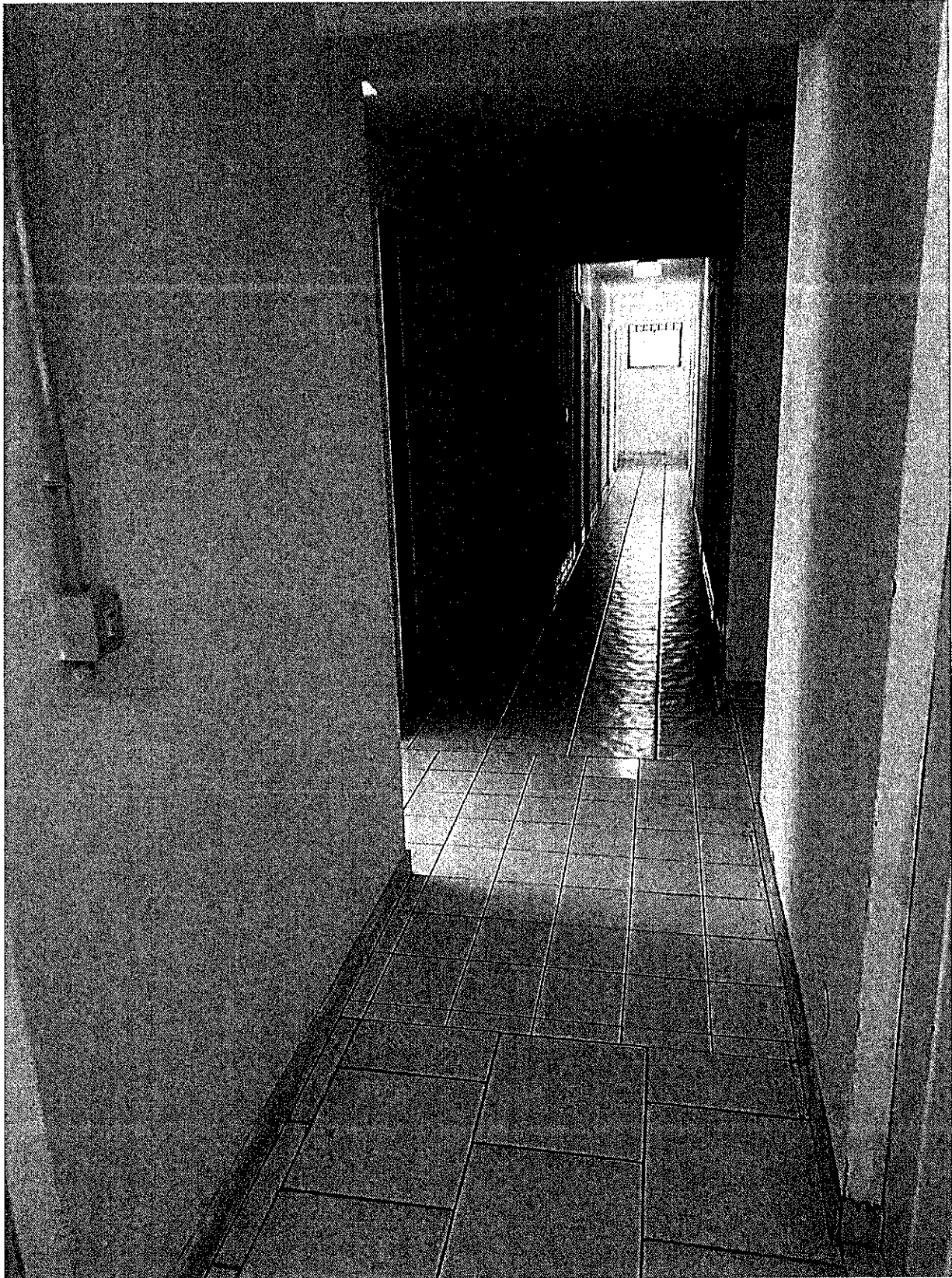
ACCESSO DAL CORRIDOIO DEL VANO SCALA ALL'AUTORIMESSA AL PIANO SEMINTERRATO
