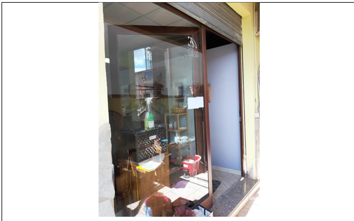
Foto 23. Infisso cortile esterno
