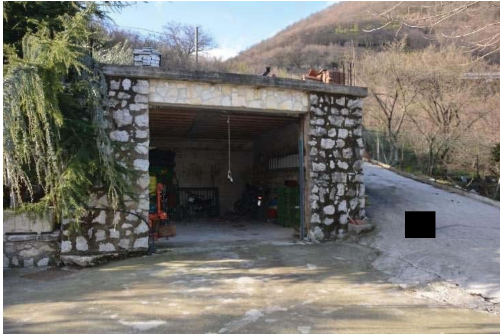
Foto 19: ingresso al deposito
