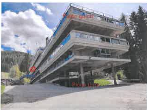
Fronte nord ed est
