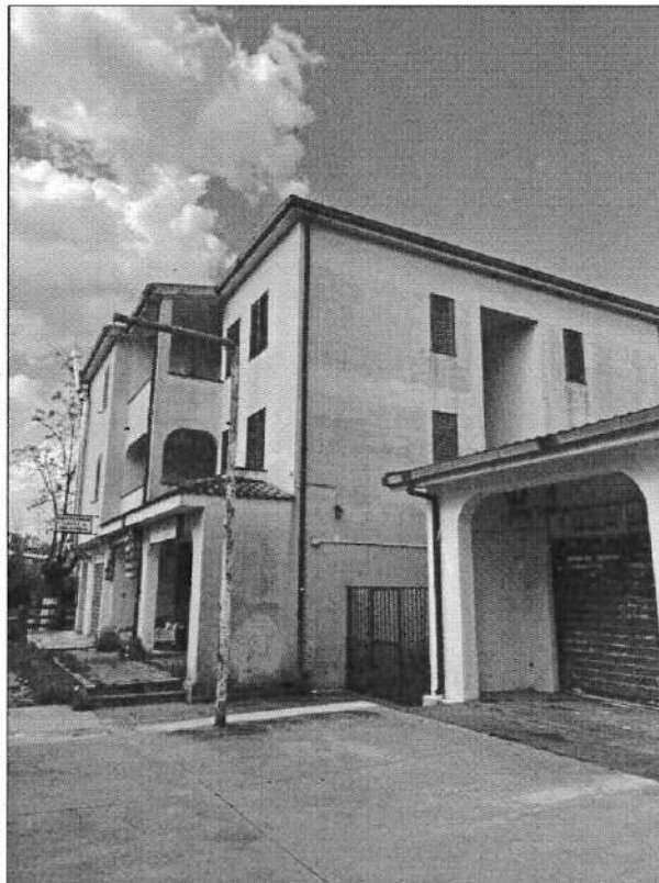
Foto 17 – Fabbricato K, part. 823
