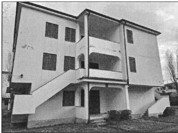
Foto 11 – Fabbricato G, part. 1147.
