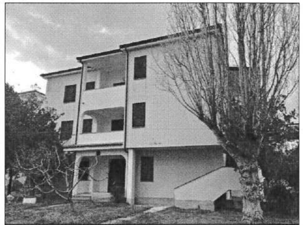
Foto 12 – Fabbricato H, part. 1148.
