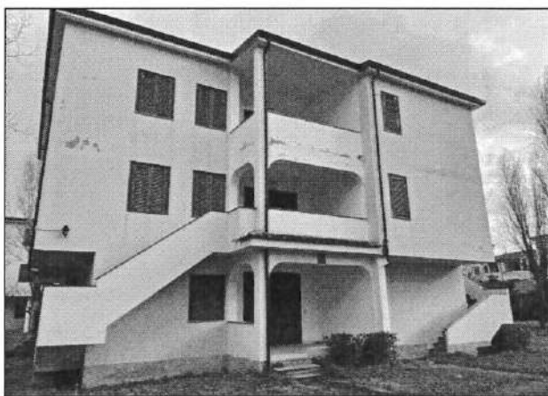
Foto 13 – Fabbricato I, part. 1145.
