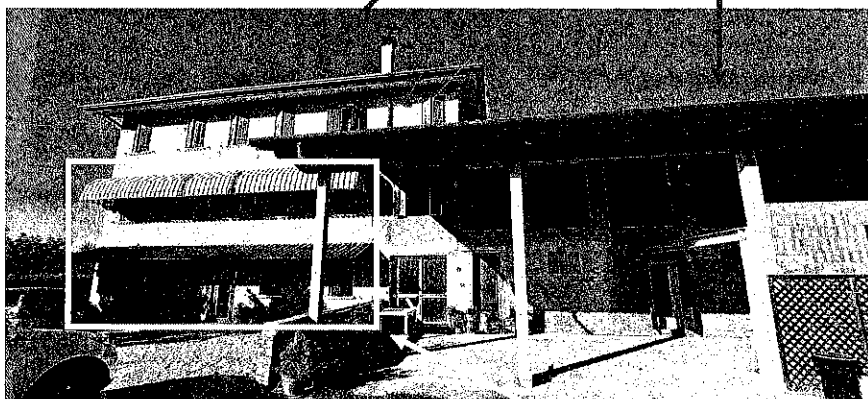
Edificio con evidenziato l'appartamento Sub. 3 non oggetto di pignoramento
