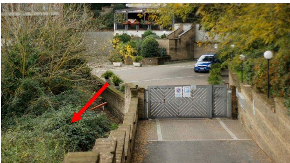
Figura 5 _ Vista dall'ingresso carrabile delle palazzine confinanti
