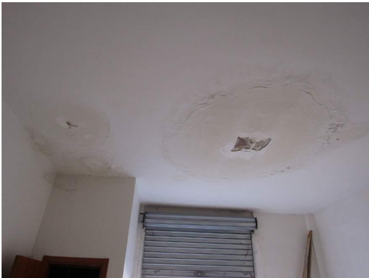
FOTO 4.5 - LOTTO 4 - LABORATORIO ARTIGIANALE IN FOGGIA - INTERNO
