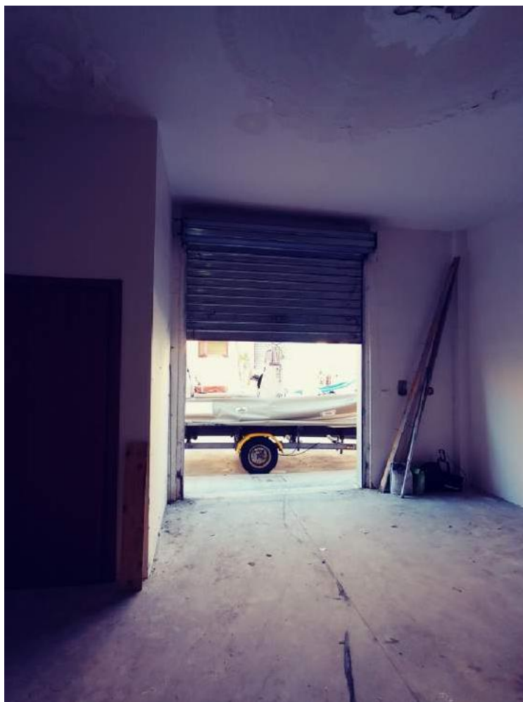
FOTO 4.3 - LOTTO 4 - LABORATORIO ARTIGIANALE IN FOGGIA - INGRESSO
