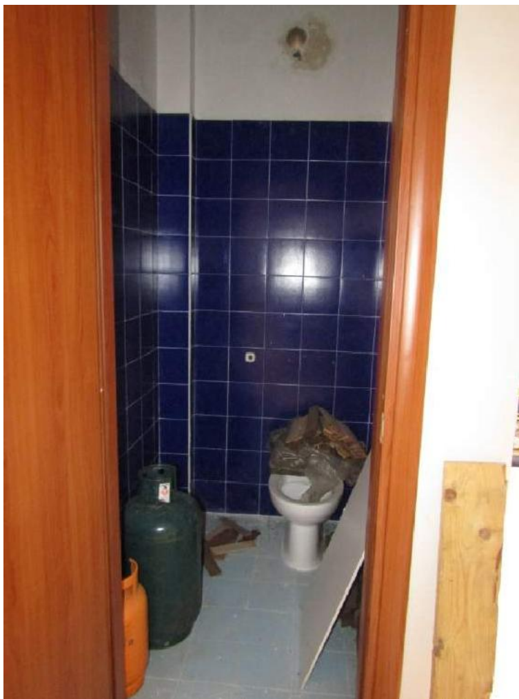
FOTO 4.7 - LOTTO 4 - LABORATORIO ARTIGIANALE IN FOGGIA - BAGNO
