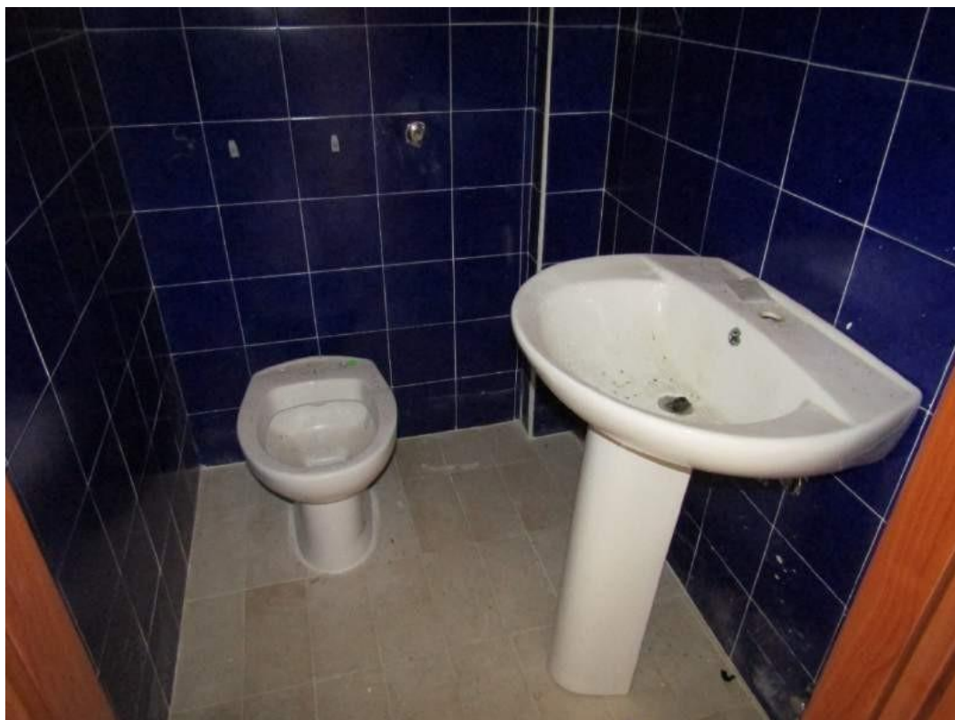
FOTO 4.8 - LOTTO 4 - LABORATORIO ARTIGIANALE IN FOGGIA - BAGNO
