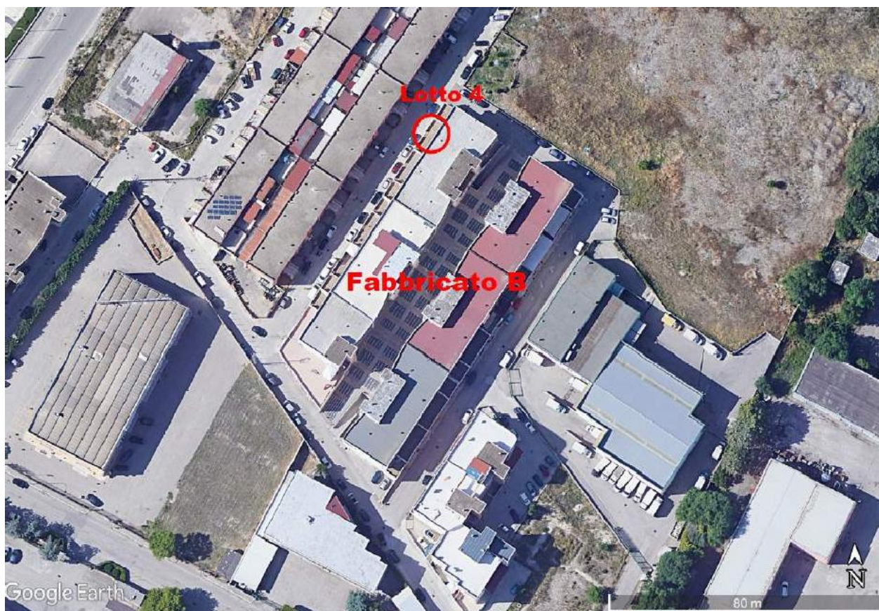
Fig. 1 - LOTTO 4 - Localizzazione dell'immobile all'interno del Fabbricato B sito in Foggia alla via Manfredonia angolo Via delle Casermette - Ortofoto
