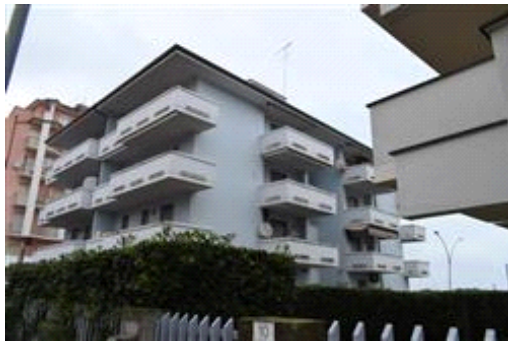
Palazzina di Via Rossini n.19
