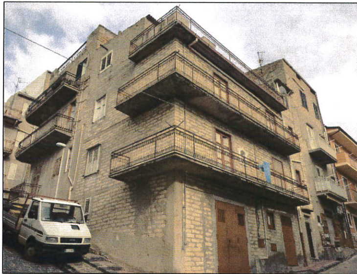
Vista angolo via Civiletti via D'arezzo
