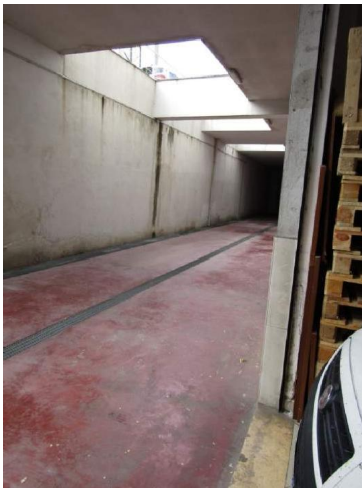
FOTO 2.16 - LOTTO 2 - LABORATORIO ARTIGIANALE IN FOGGIA - PRIMO PIANO INTERRATO - CORSIA DI MANOVRA
