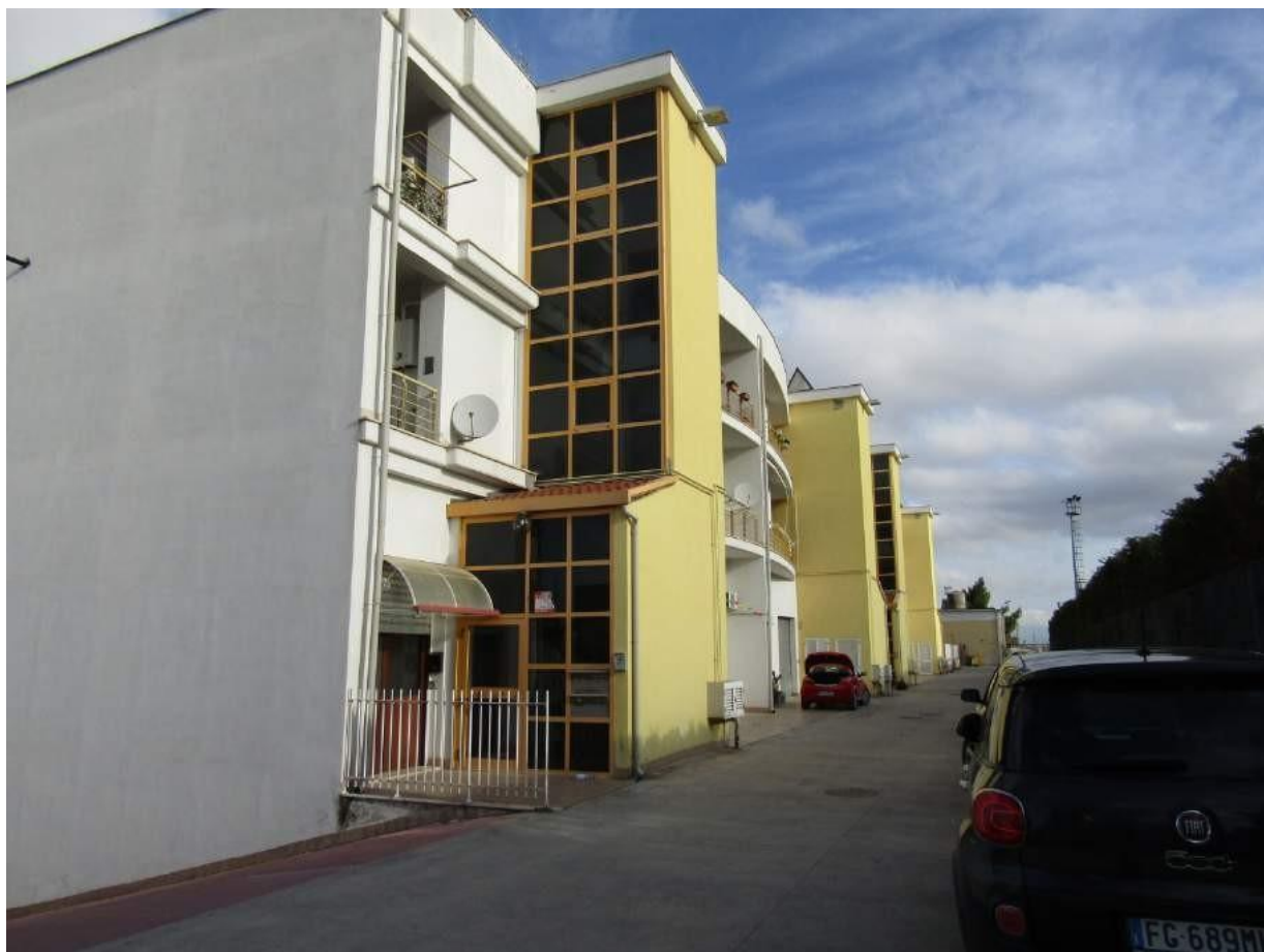
FOTO 2.2 - LOTTO 2 - LABORATORIO ARTIGIANALE IN FOGGIA - FABBRICATO A - PROSPETTO SECONDARIO
