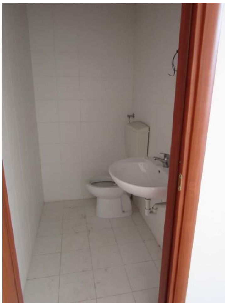
Foto 2.10 - LOTTO 2 - LABORATORIO ARTIGIANALE IN FOGGIA - PIANO TERRA - BAGNO
