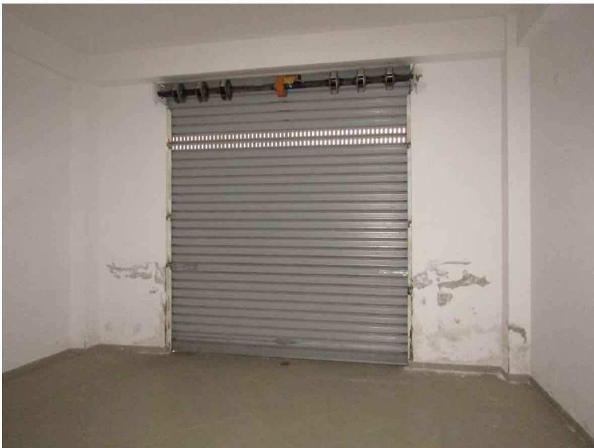
FOTO 2.15 - LOTTO 2 - LABORATORIO ARTIGIANALE IN FOGGIA - PRIMO PIANO INTERRATO - INGRESSO CARRABILE
