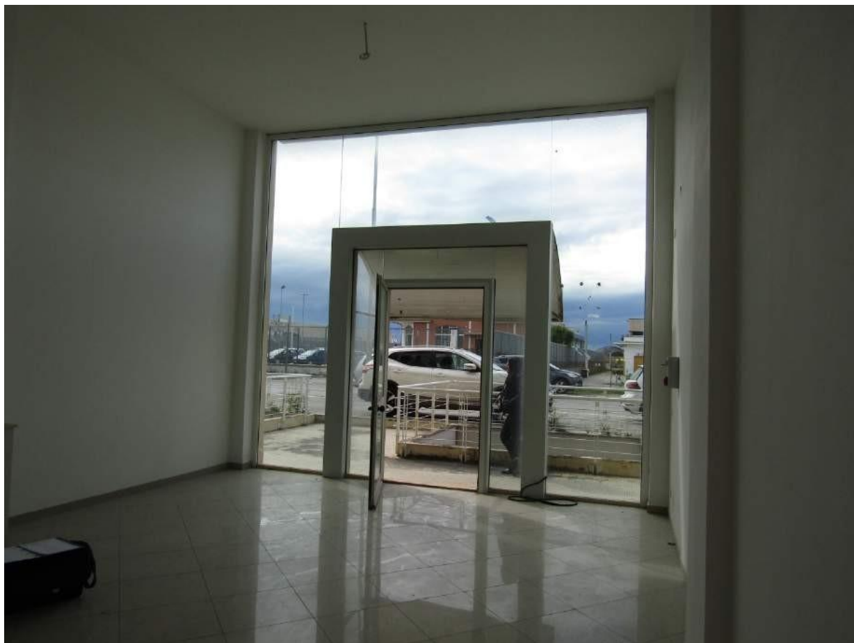
Foto 2.8 - LOTTO 2 - LABORATORIO ARTIGIANALE IN FOGGIA - PIANO TERRA -INTERNO
