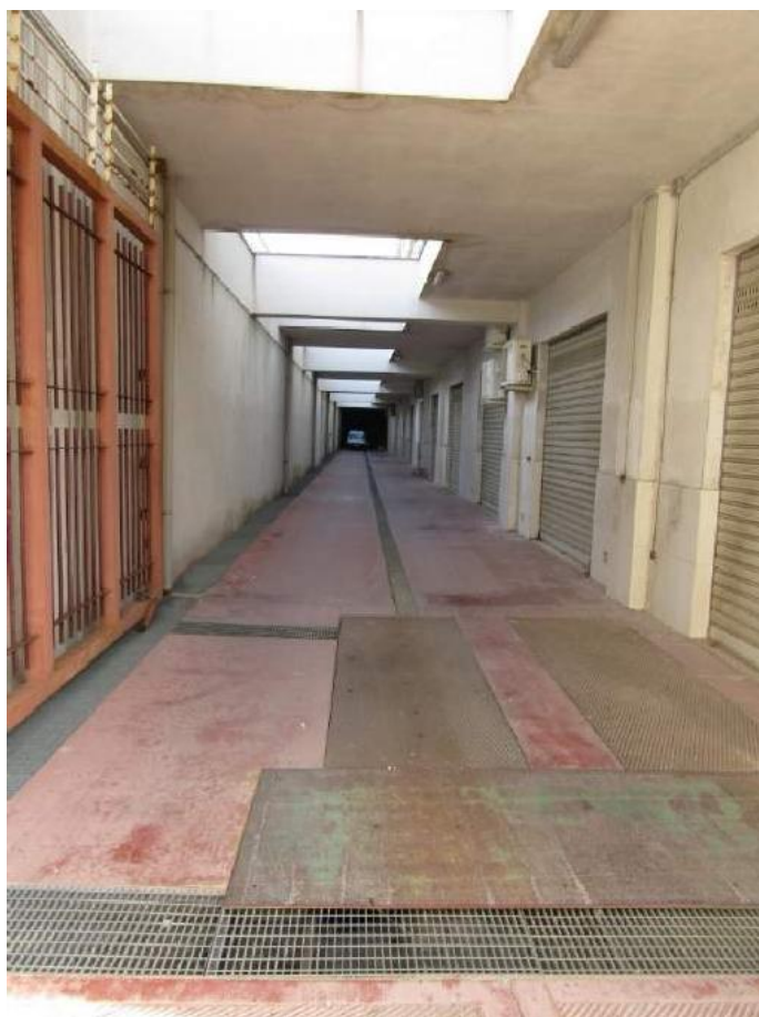
Foto 2.4 - LOTTO 2 - LABORATORIO ARTIGIANALE IN FOGGIA - FABBRICATO A - PIANO S1- CORSIA DI MANOVRA
