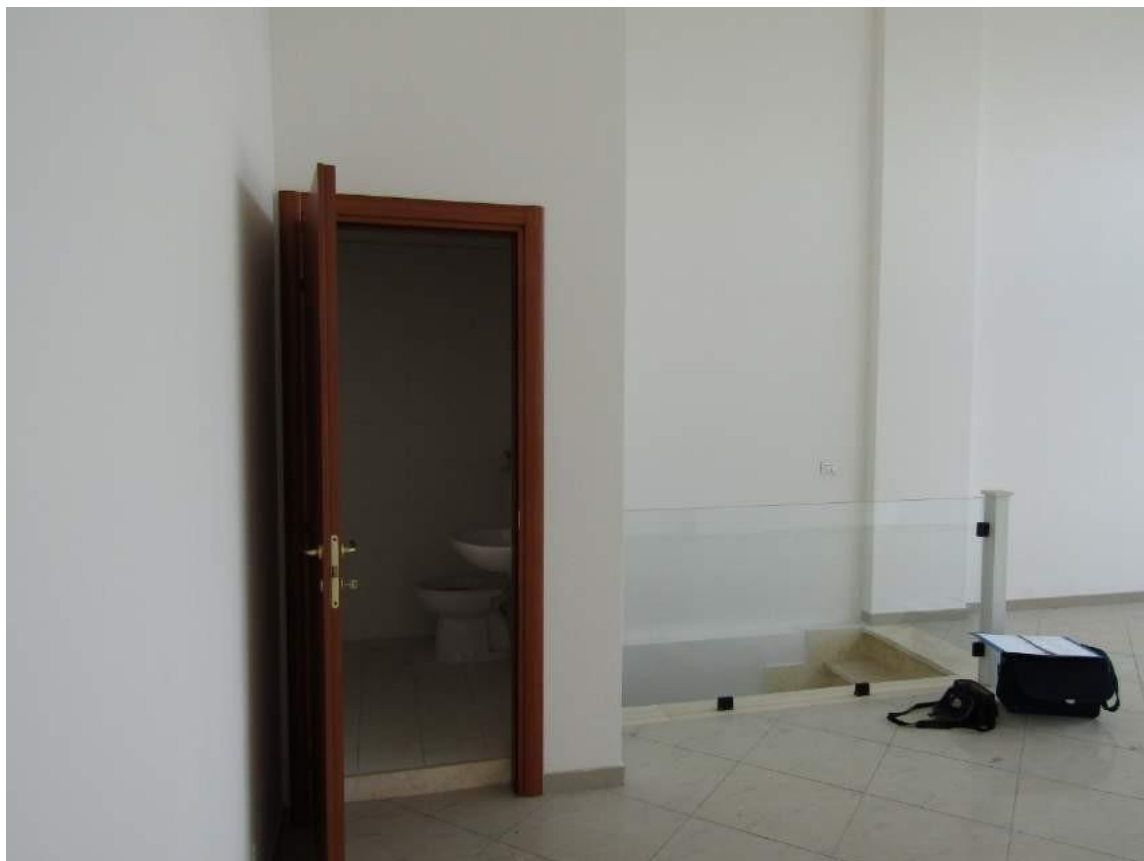
Foto 2.9 - LOTTO 2 - LABORATORIO ARTIGIANALE IN FOGGIA - PIANO TERRA - INTERNO
