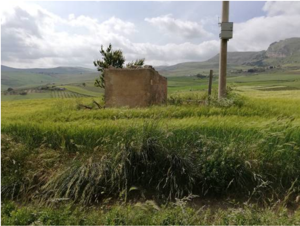
Foto n. 3 – Piccolo fabbricato insistente sulla p.lla 134
