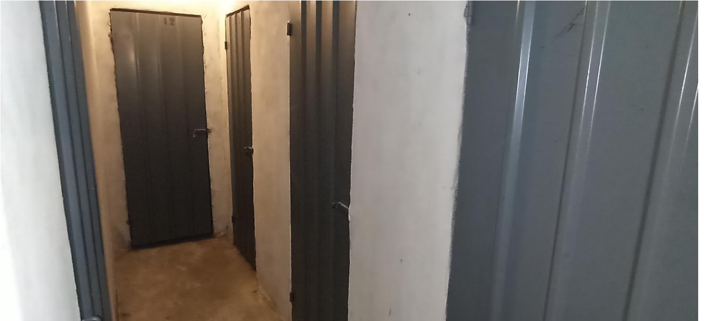
VISTA INTERNA CANTINA
