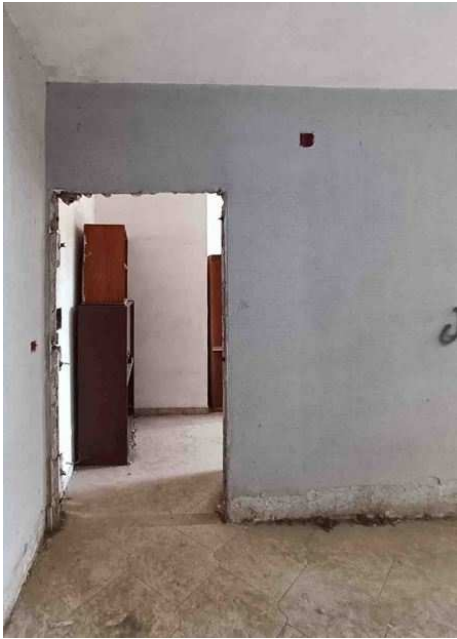
Porta di ingresso all'immobile
