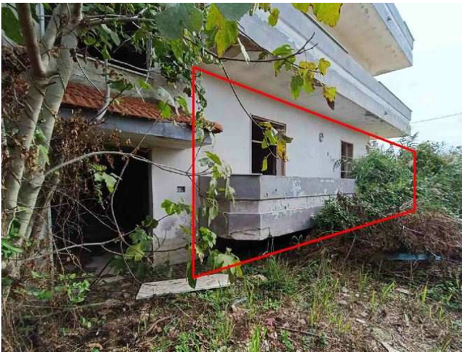
Vista dall'esterno - lato ovest
