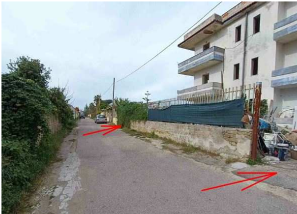
Accessi da Via Cremona
