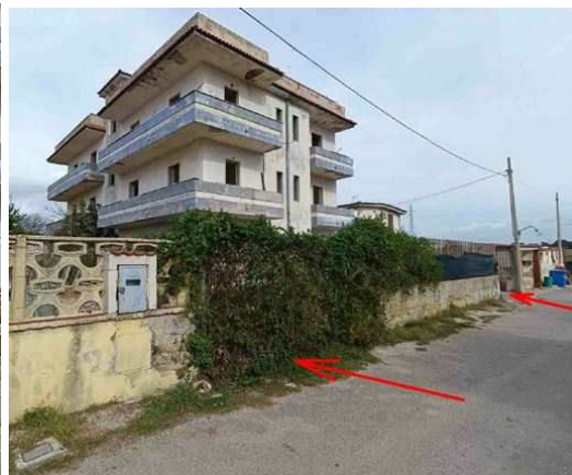
Accessi da Via Cremona
