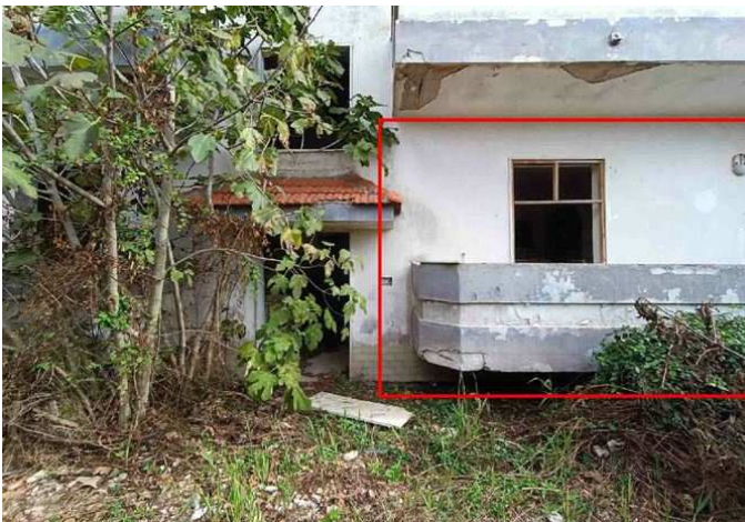
Vista dall'esterno - lato ovest
