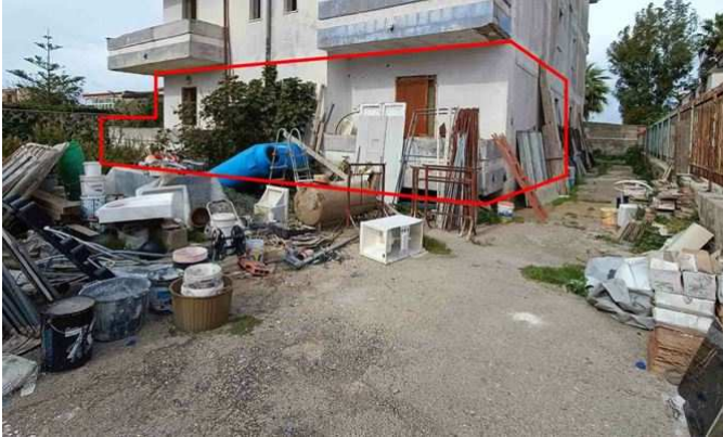
Vista dall'esterno - lato sud/est
