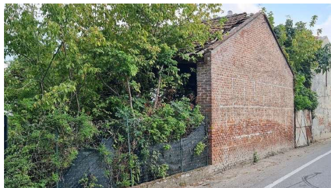
2. Veduta del rustico dalla via Patrini
