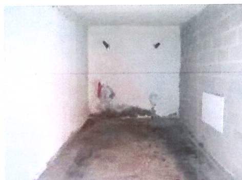
Vista interno autorimessa
