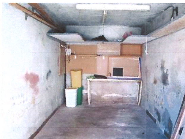
Vista interno autorimessa
