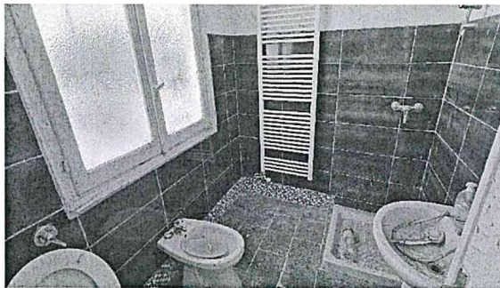
11. Servizio igienico Piano ammezzato
