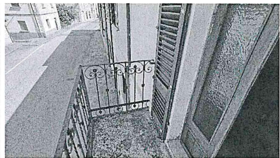
16. Balcone su fronte strada
