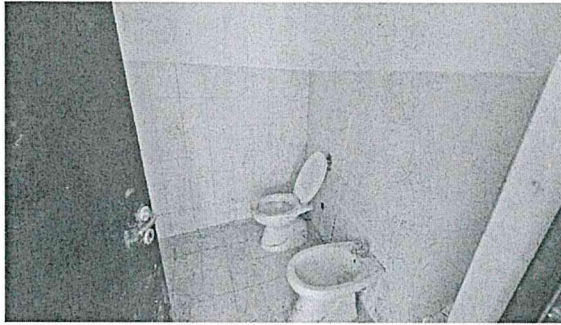
9. Servizio igienico Piano terra
