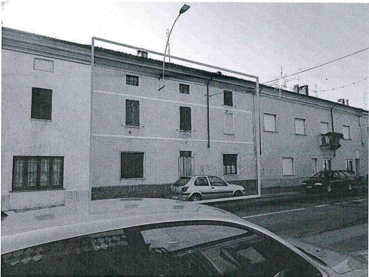
Prospetto principale su Via Borgoratto
