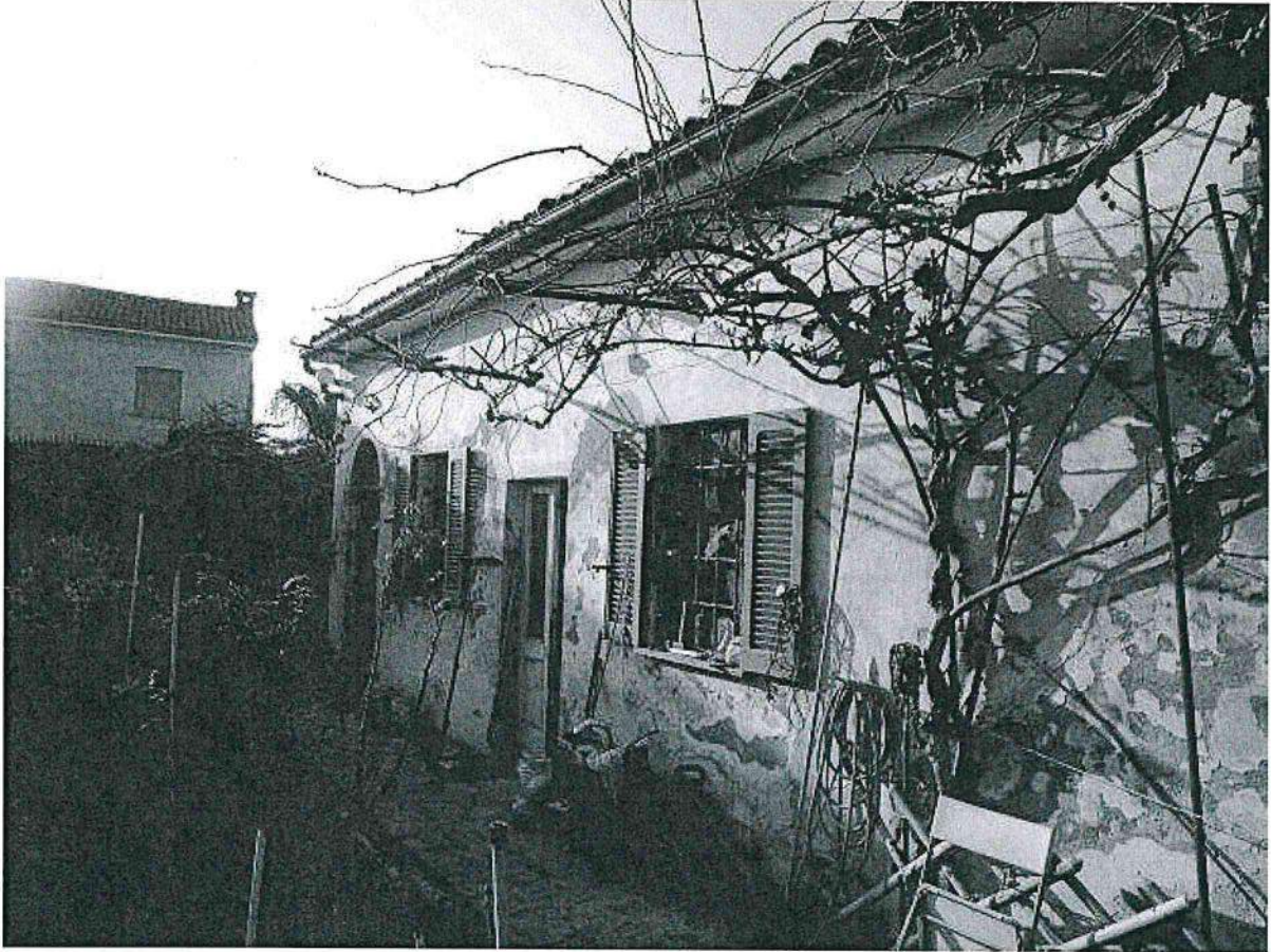
Prospetto secondario su cortile lato Sud
