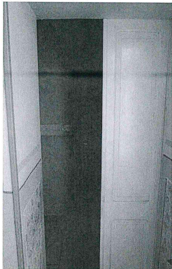
Foto 14 - disimpegno accesso 1P ammezzato
