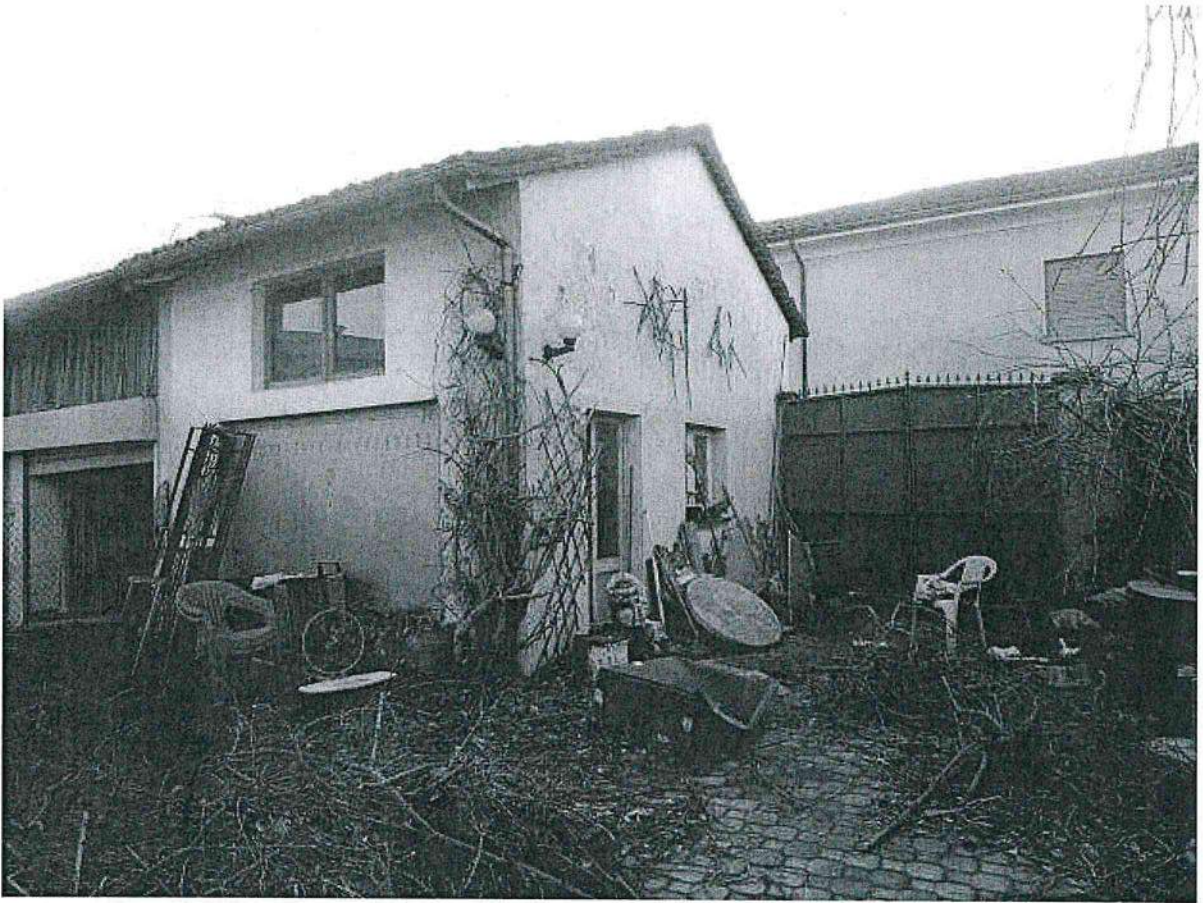
Cortile lato Ovest e autorimessa
