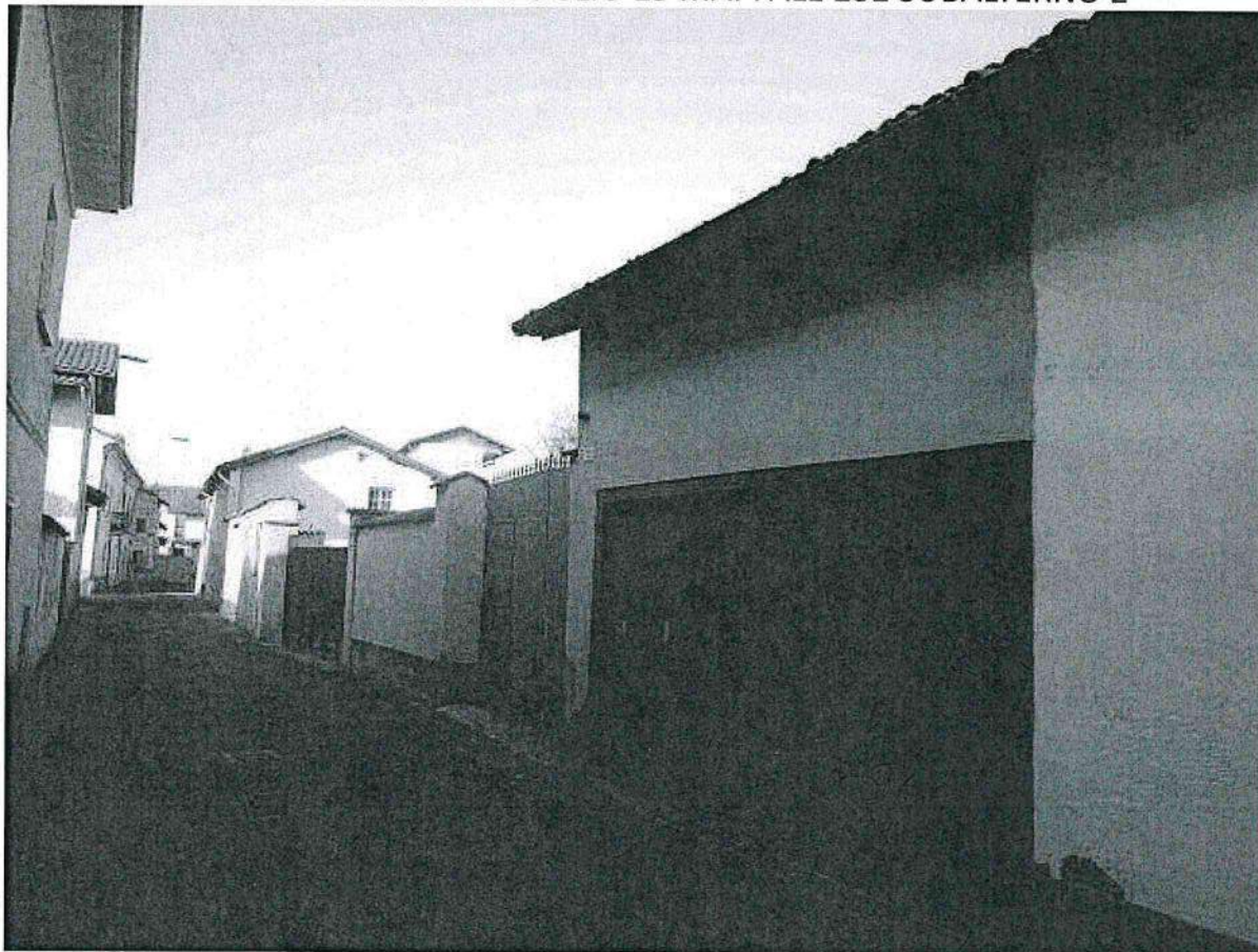
Accesso al cortile e al box autorimessa da via Dè Reali
