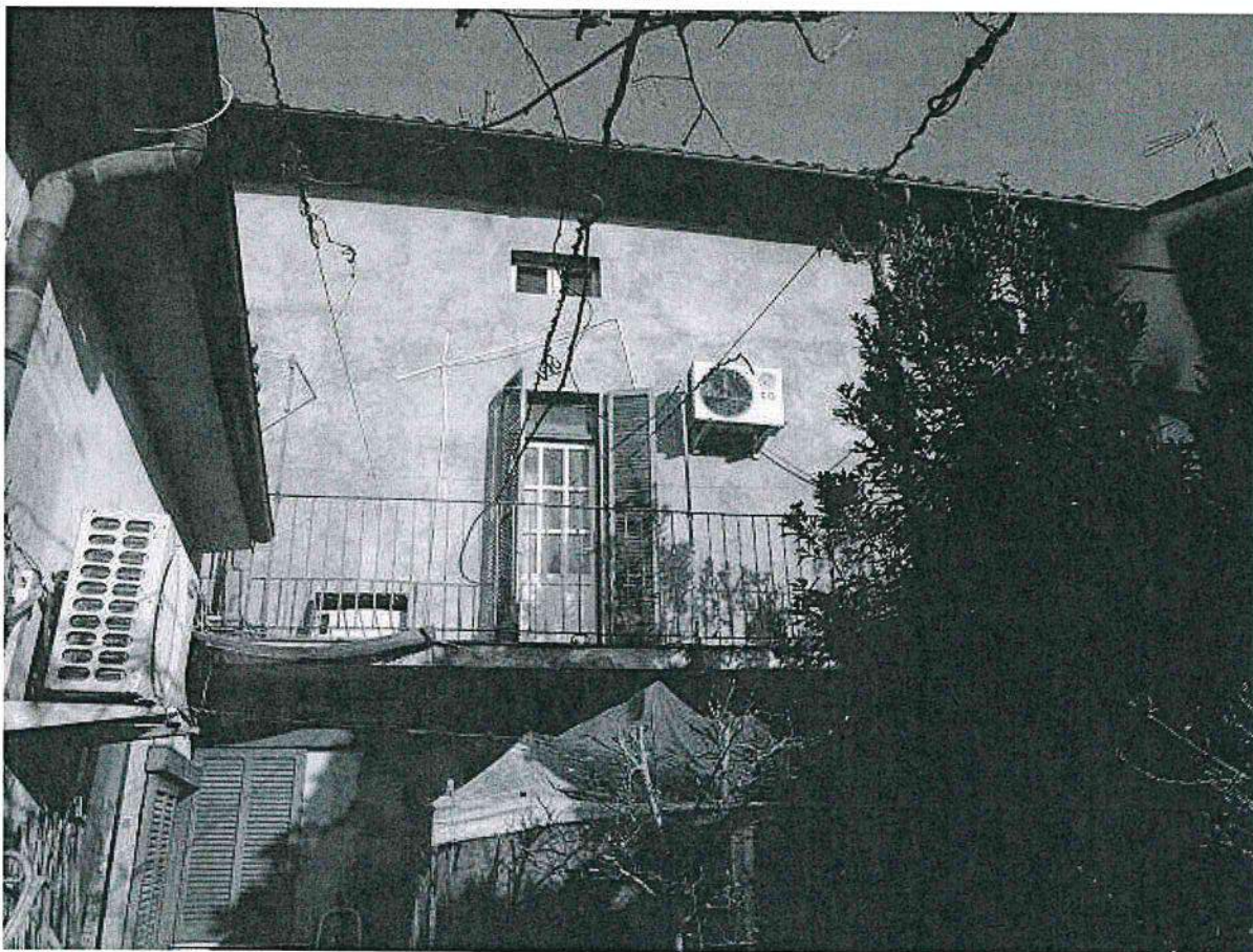
Prospetto secondario su cortile lato Ovest
