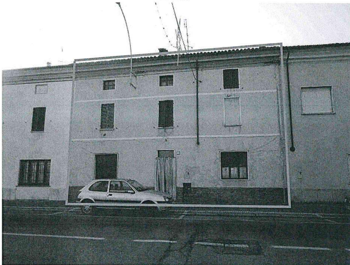
Prospetto principale su Via Borgoratto
