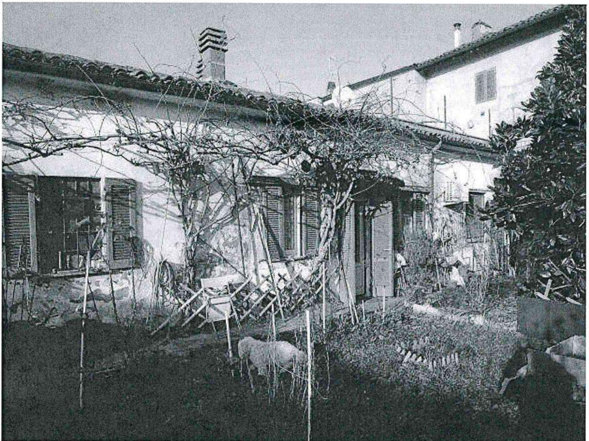
Prospetto secondario su cortile lato Sud
