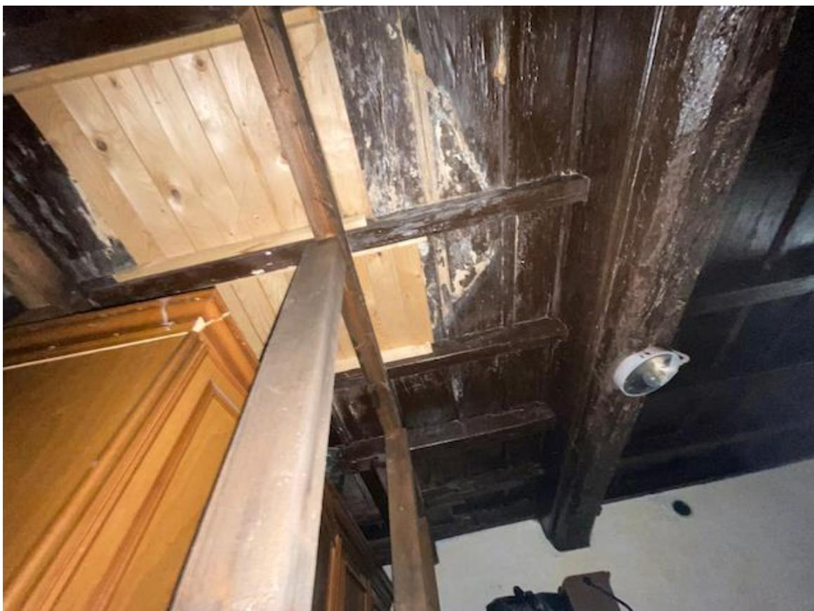
**PIANO TERRA – Locale di Sgombero – particolare ammaloramento soletta puntellata in modo provvisorio**
