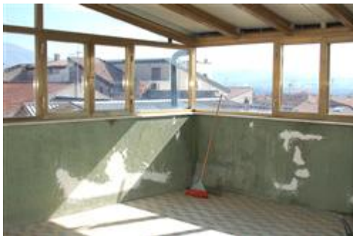
Vano terrazzo piano mansarda
