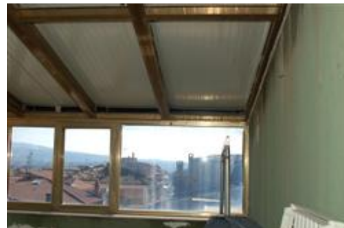
Vano terrazzo piano mansarda
