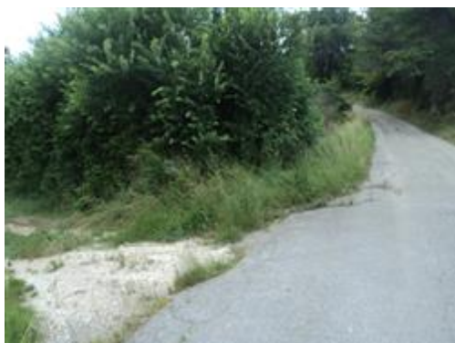
Incrocio tra strada "Contrada Fontesecca" e strada di accesso al Lotto1
