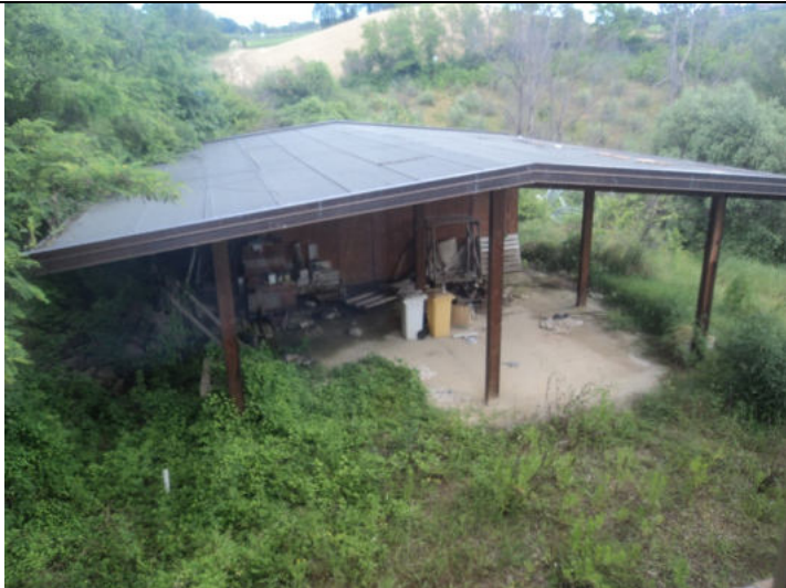
Fienile PT Sub.6 copertura
