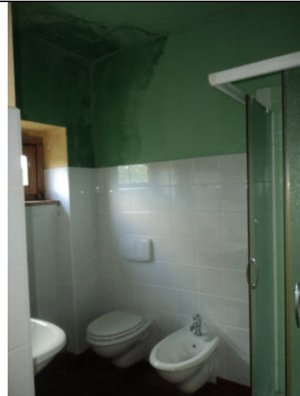
Bagno della Camera 3 P1 sub 2
