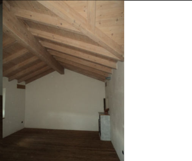
Magazzino PT Sub. 4
