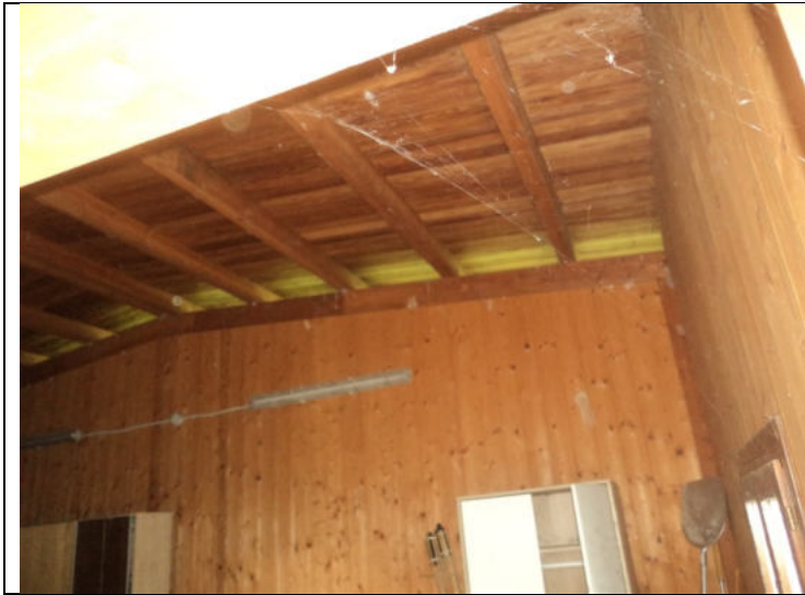
Fienile PT Sub.6 interno e particolare tetto
