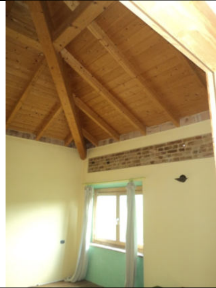
Camera 4 P2 sub 2 particolare tetto
