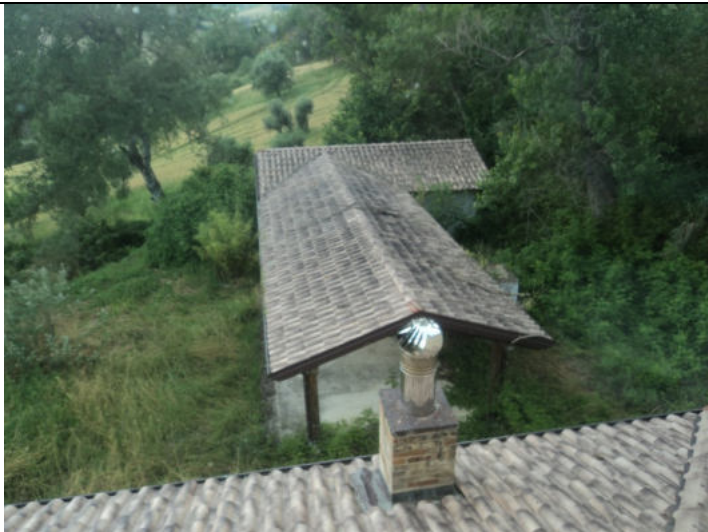
Magazzino Sub.4 copertura
