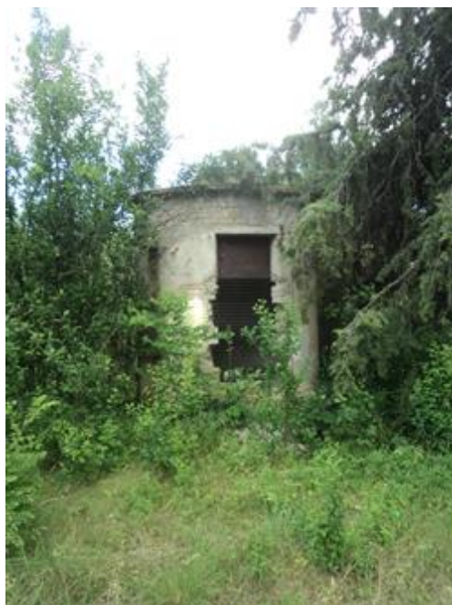
Subalterno 5, silos fatiscente
