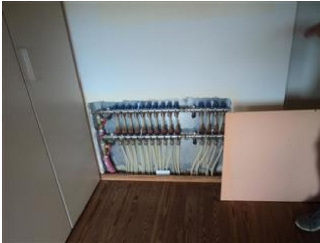
Collettore generale Subalterni 2-3
