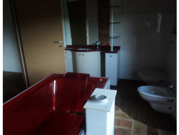
Bagno della Camera 4 P2 sub 2
