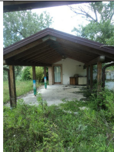
Magazzino PT Sub.4 tettoia
