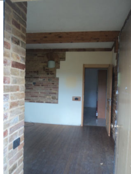
Ingresso fabbricato PT sub 3
