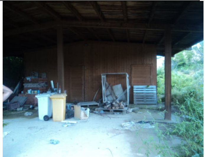
Fienile PT Sub.6 tettoia
