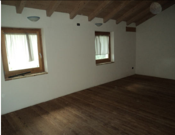
Magazzino PT Sub.4
