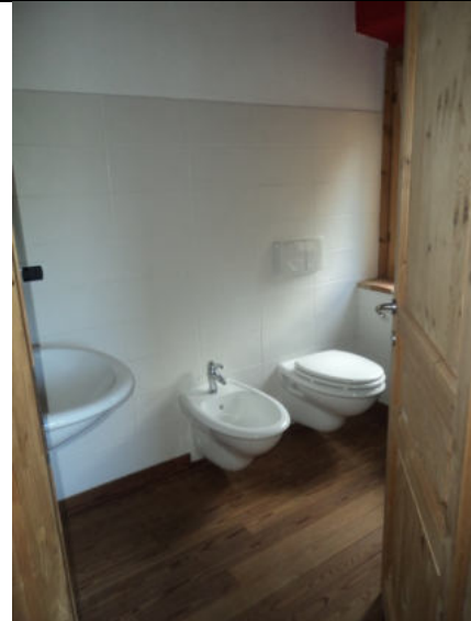
Bagno della Camera 2 P1 sub 2
