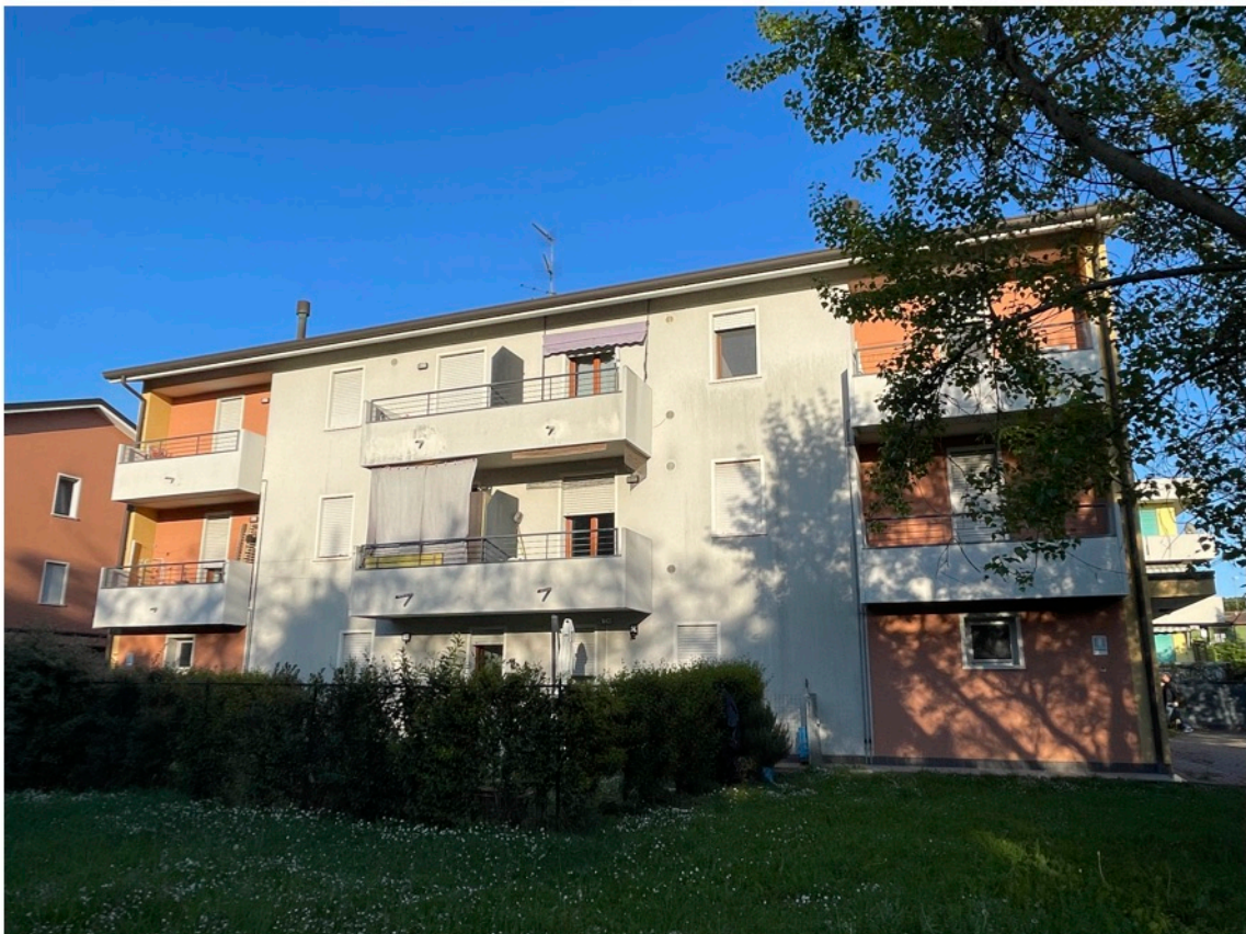
29 - Vista fabbricato lato ovest
