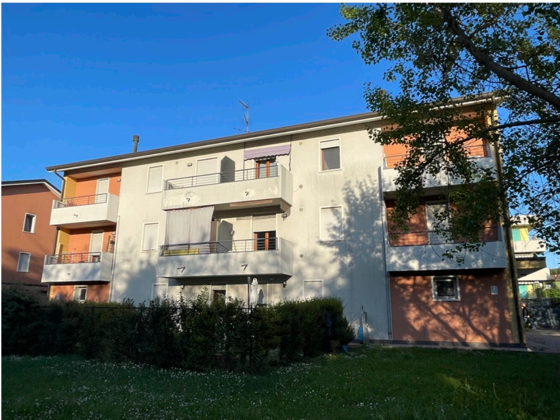
29 - Vista fabbricato lato ovest
