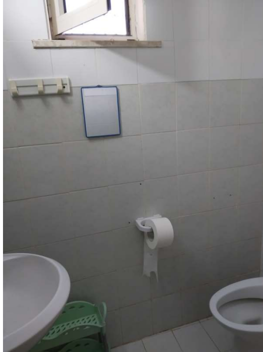
Foto 10 Particolare di uno dei W.C.
