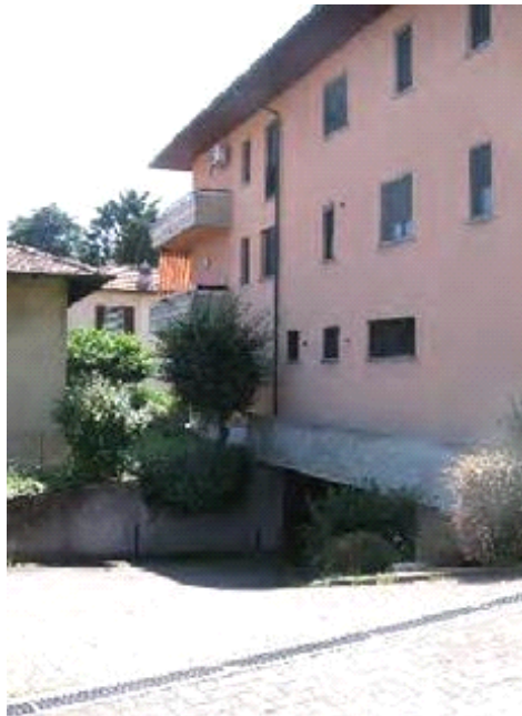
Vista rampa di accesso autorimesse al PSI
