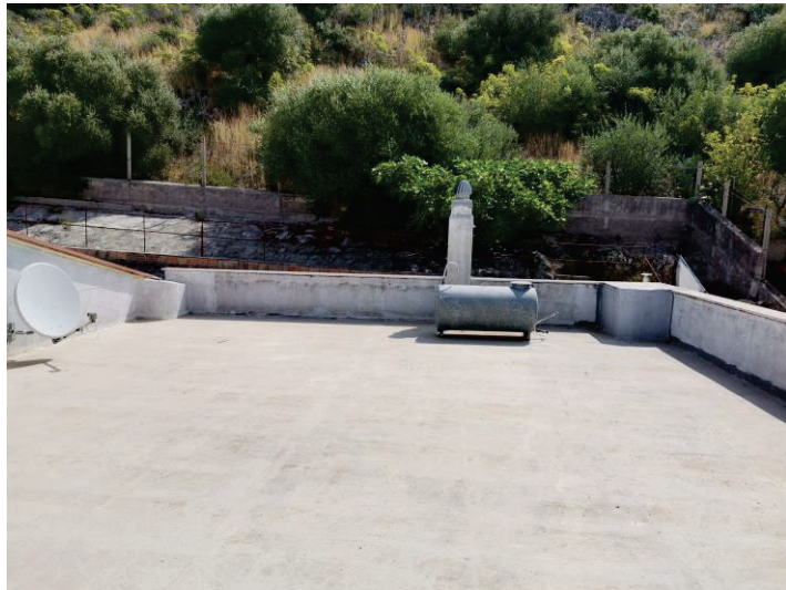
LOTTO 4 il lastrico solare sub 8
