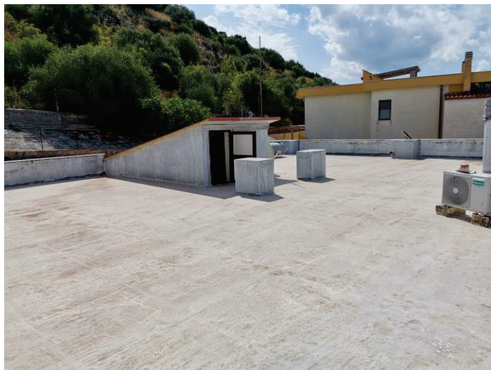
LOTTO 4 il lastrico solare sub 8
