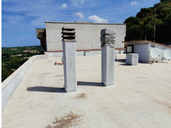
LOTTO 4 il lastrico solare sub 8
