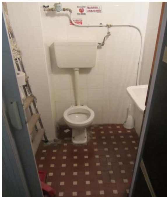
FOTO N° 79: VISTA GENERALE DEL W.C. RILEVATO AL SUO INTERNO.
