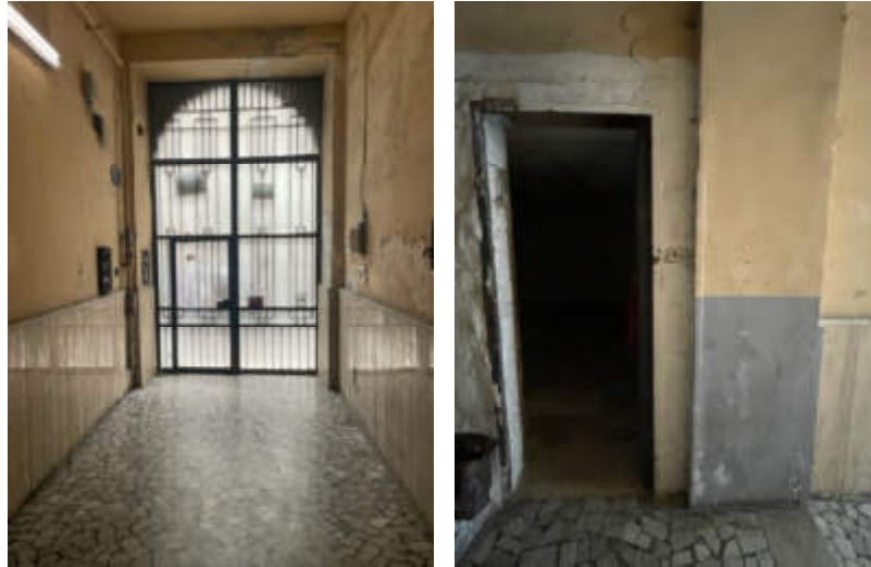
Androne di ingresso e porta di ingresso al cespite
