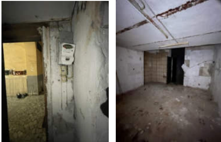
Viste interne dell'immobile – porta di ingresso al cespite e vano soppalcato
