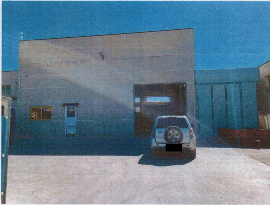
Foto n. 1: Prospetto principale capannone
