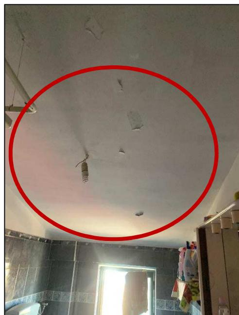
**Foto 25-26-27-28: Dettagli dei fenomeni infiltrativi e delle porzioni di intonaco distaccato presenti nel disimpegno e sul soffitto del bagno.**
