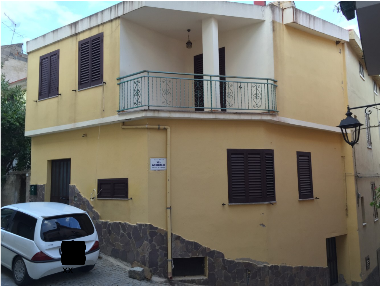
Foto n. 1 Abitazione in via Podda, Loceri
