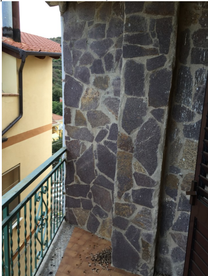
Foto n. 11: balcone piano primo abitazione in via Podda, Loceri
