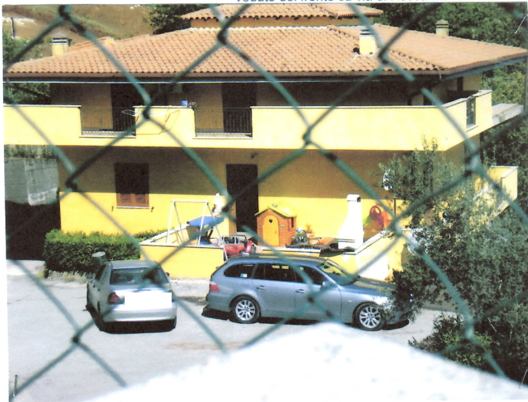
Vedute del fronte su via di Rocca Massima
