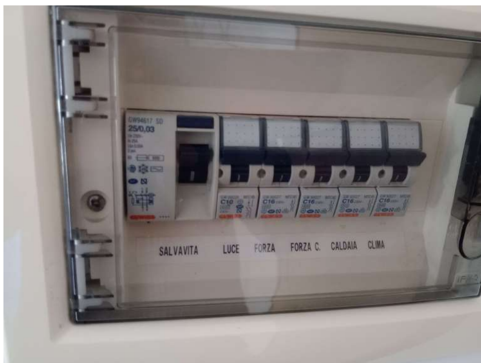
Particolare quadro elettrico
