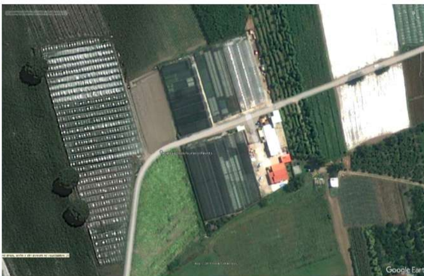
Rilievo satellitare serre e fabbricati anno 2011
