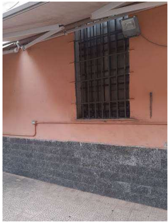
Foto 17 Esterno Finestra laterale
