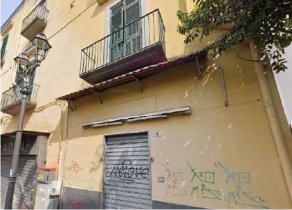
Foto 12 Ingresso Locale Commerciale
