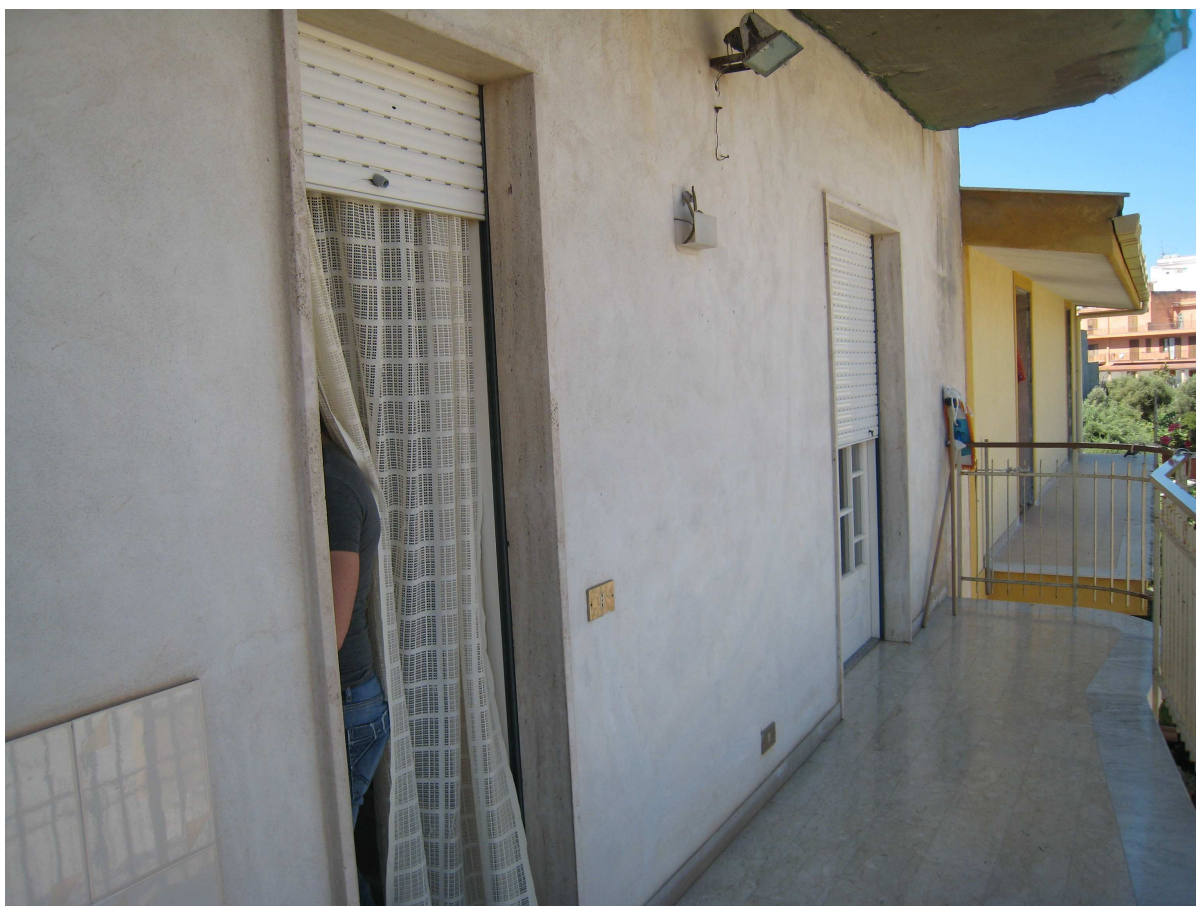
Foto n. 52. Il balcone che si apre sulla via Senna.
