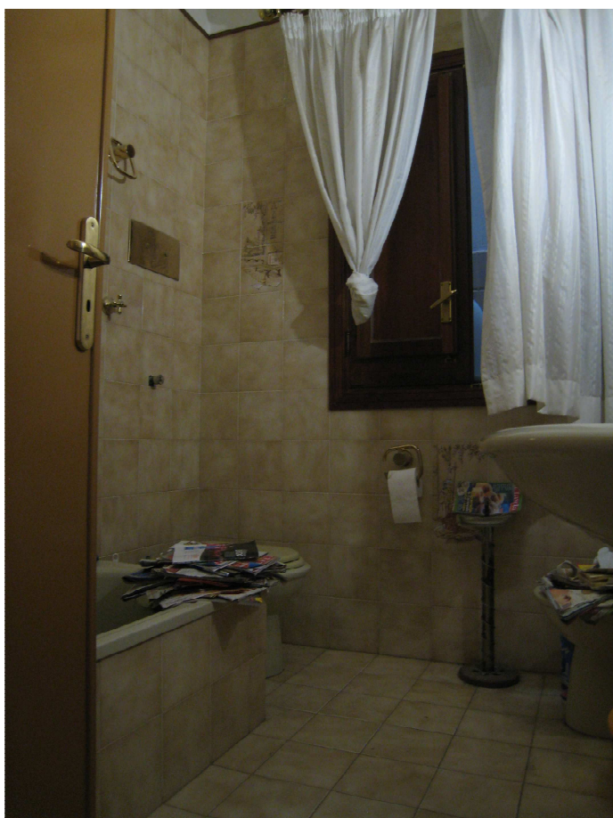
Foto n. 21. Il w.c. bagno sdi apre anch'esso nel pozzo luce.
