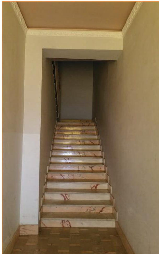
Foto 2 - Vista Sul vano scala
