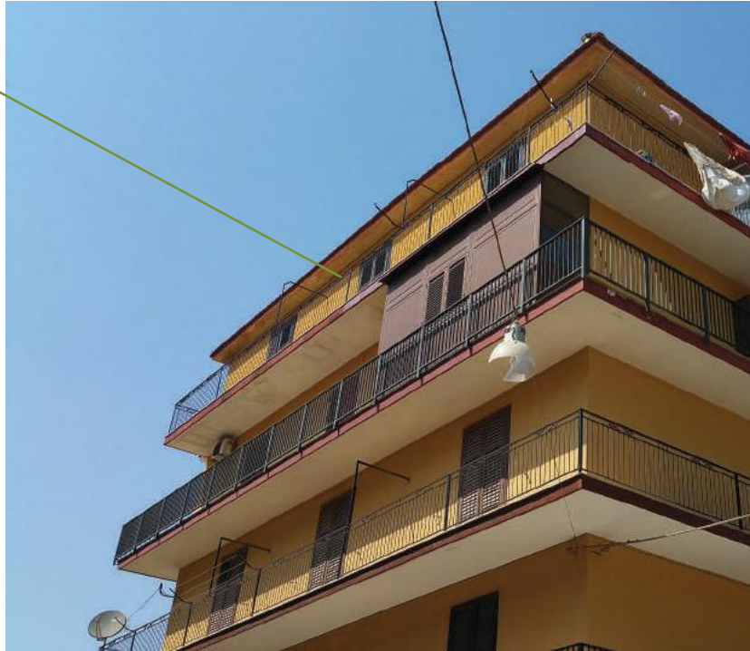
Foto 1 - Vista Complesso Edilizio - lato Sud
