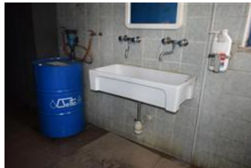
Locali a spogliatoio e servizi igienici
