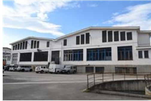
Facciata principale del fabbricato di cui le unità immobiliari costituenti il Lotto sono parte
