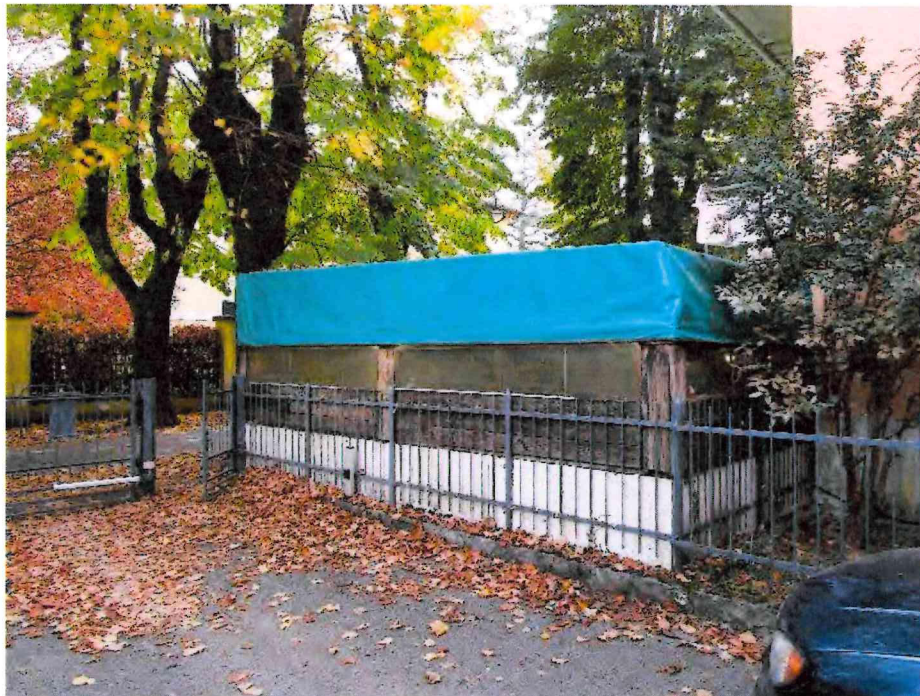
4. Lotto vista facciata Nord-Est
