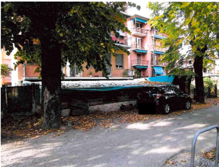
2. Lotto vista facciata Sud-Est
