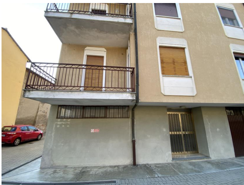
FOTO 7: appartamento al P.1 oggetto di E.I. (fronte verso strada) – portoncino d'ingresso al vano scala
