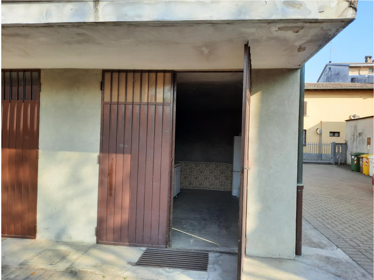
FOTO 23: autorimessa al P.T.
