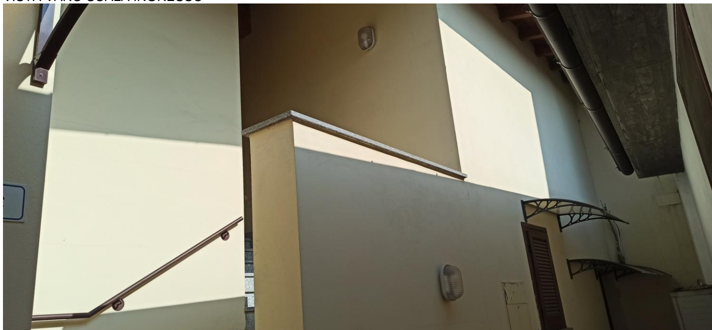
VISTA VANO SCALA INGRESSO
