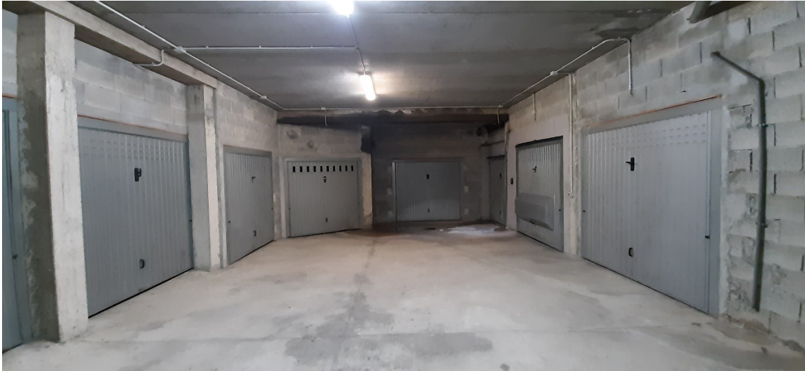
(PARTICOLARE AREA BOX AUTO)
