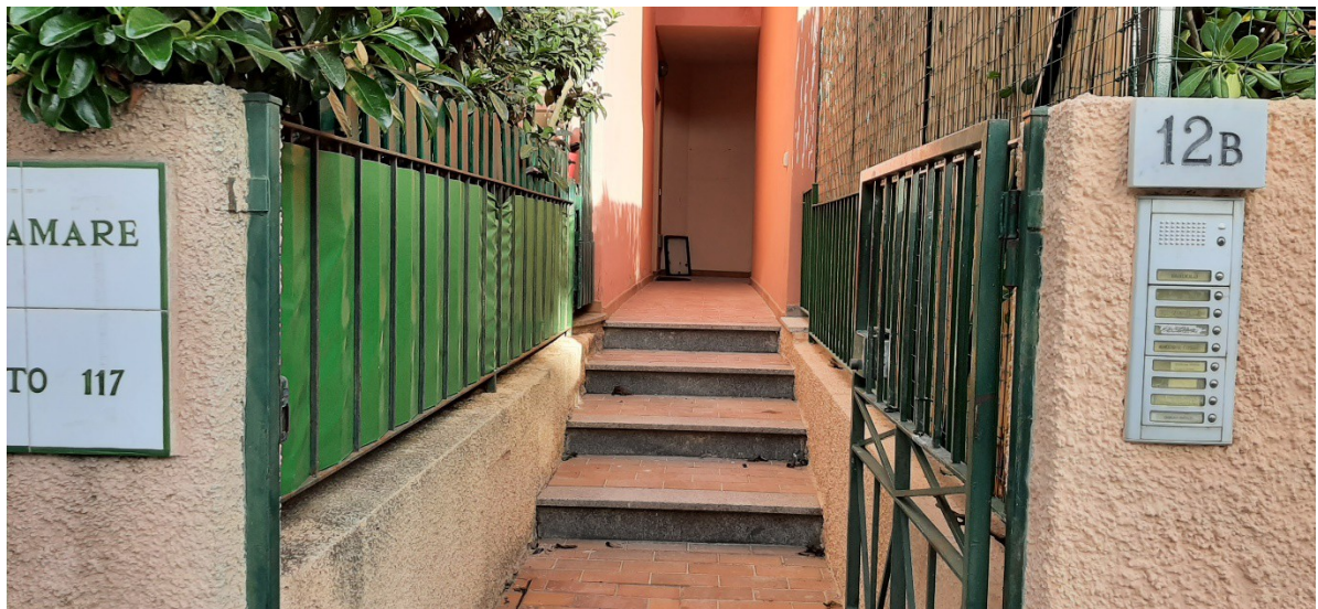
(ACCESSO AL FABBRICATO DA VIA PUBBLICA DEOMINATA VIA PAVESE)
