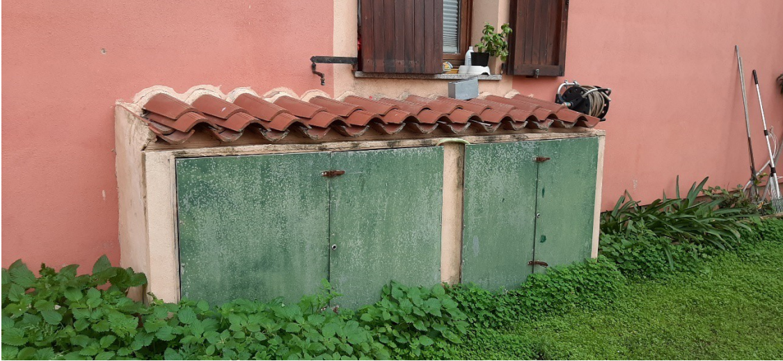
(ALLOGGIAMENTO BOMBOLE GAS – NON AUTORIZZATO)
