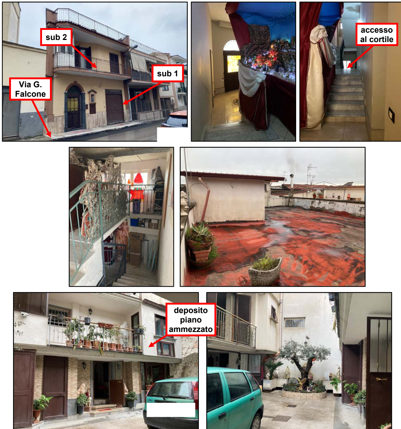
Corpo di fabbrica "A" - sub 1 e sub 2 e parti comuni (ingresso, corridoio, scala, lastrico di copertura, cortile)
