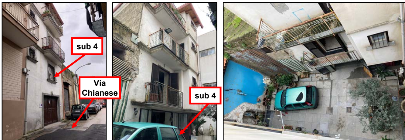
Corpo di fabbrica "B" - sub 4 - prospetto su Via Chianese e accesso al cortile
