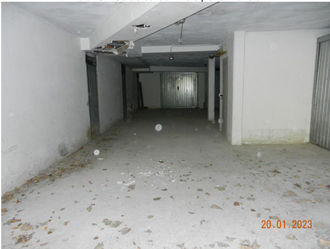
Foto 10 – Corsia condominiale piano interrato
