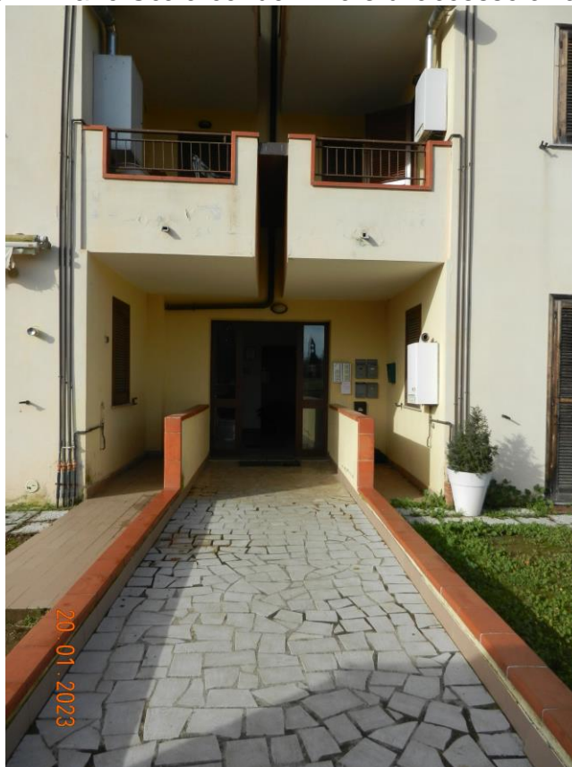
Foto 02 – Vano Scala condominiale di accesso all'alloggio
