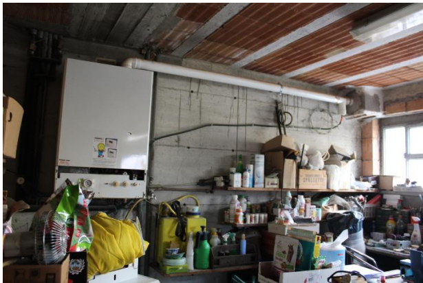
LEGNAIA OVE POSTA LA CALDAIA CON TUBAZIONE EMISSIONE FUMI IN CANNA FUMARIA, PER LA QUALE NON E' DATO SAPERE SE ESEGUITA O MENO A NORMA DI LEGGE
