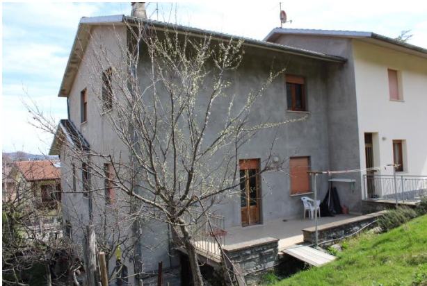
PROSPETTI NORD A SINISTRA E OVEST A DESTRA CON EVIDENZA DEL TERRAZZO SUL RETRO IN BUONA PARTE NON REGOLARE
