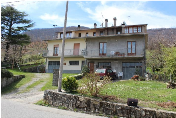
PROSPETTO FRONTE STRADA – LA PORZIONE DI BIFAMILIARE OGGETTO DI STIMA E' QUELLA POSTA A DESTRA, NON TINTEGGIATA
