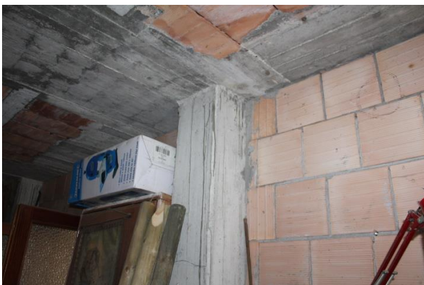
PARTICOLARE STRUTTURA IN CEMENTO ARMATO
