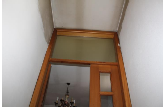
PARTICOLARE TINTEGGIATURA AL PIANO SECONDO, ZONA SCALA
