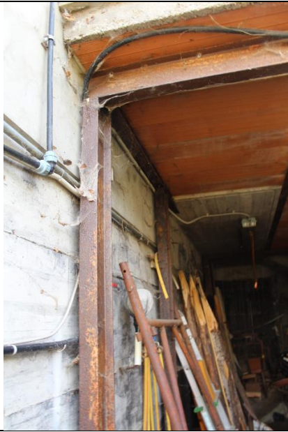
PARTICOLARE STRUTTURA PORTANTE IN FERRO
