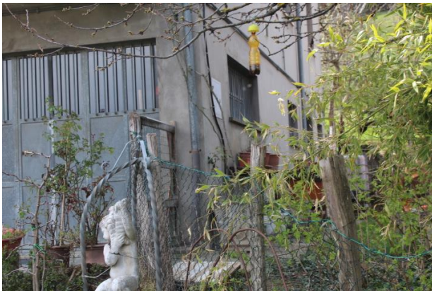
VANO A MURO, CONTATORE ENEL
