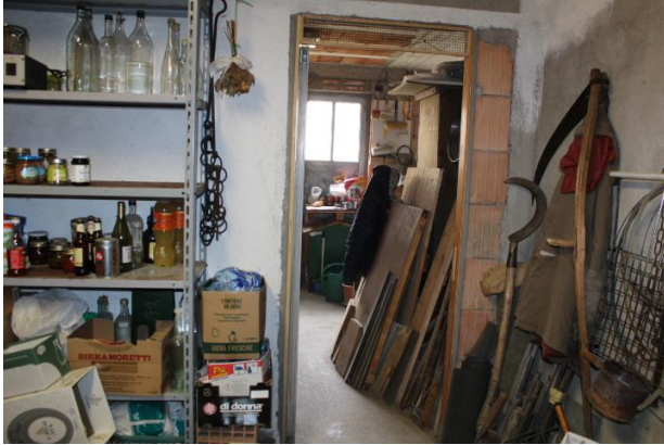
CANTINA, VISTA VERSO LA LEGNAIA
