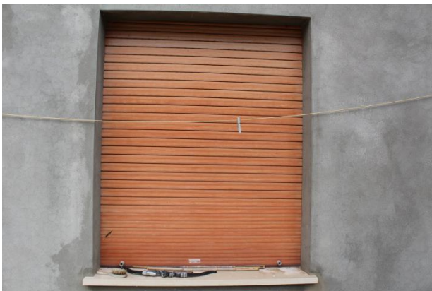
PARTICOLARE AVVOLGIBILE ESTERNO IN PVC
