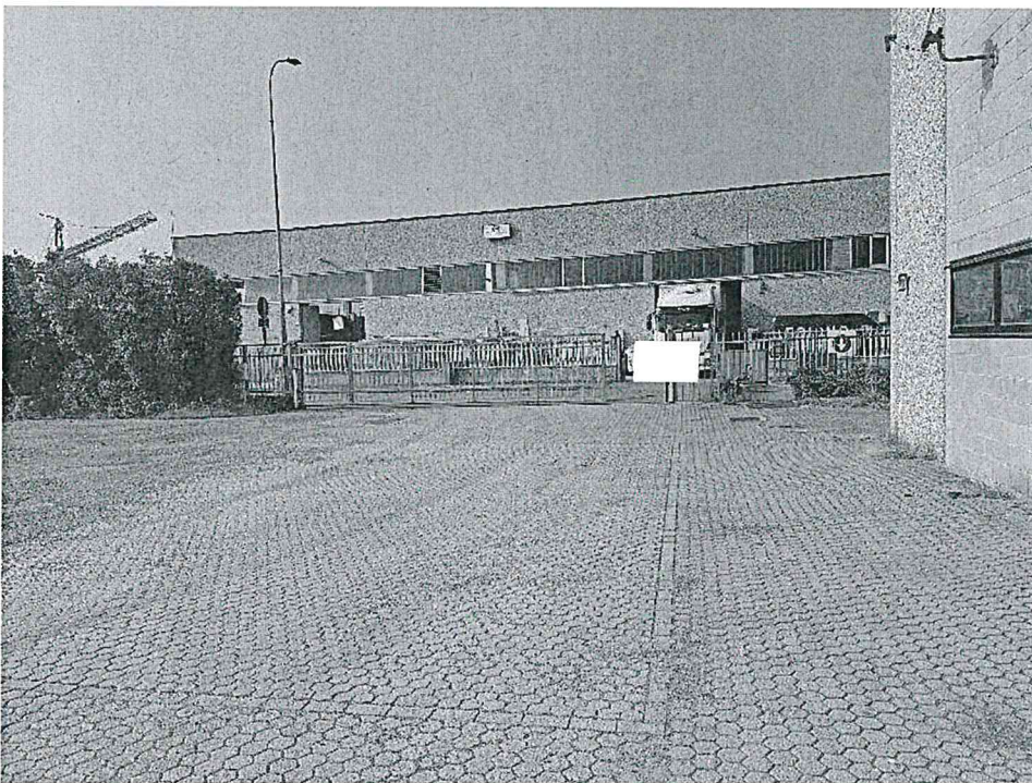
6. Mappale 488, accesso all'area in comune con il mappale 485 sulla destra.
